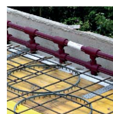
Deckenaufbau mit Schalung
