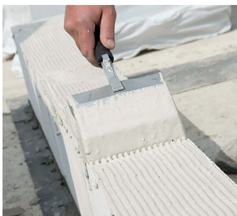
Lagerfugenausbildung: links: Porenbeton, rechts: Kalksandstein
