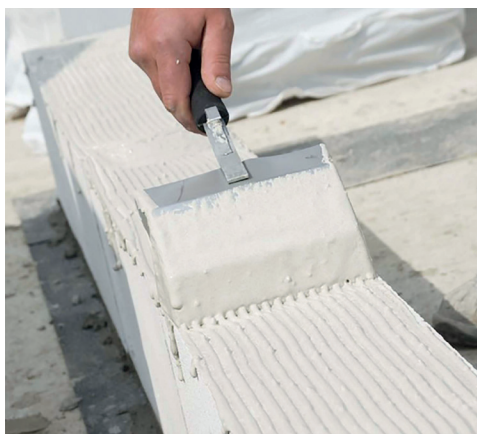
Lagerfugenausbildung: links: Porenbeton, rechts: Kalksandstein
