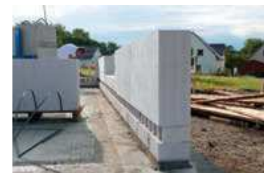
Ein horizontaler Verteilungskanal in Sockelhöhe sowie zahlreiche vertikale Leerkonäle sorgen für eine einfache und flexible Verlegung der Elektroleitungen.
