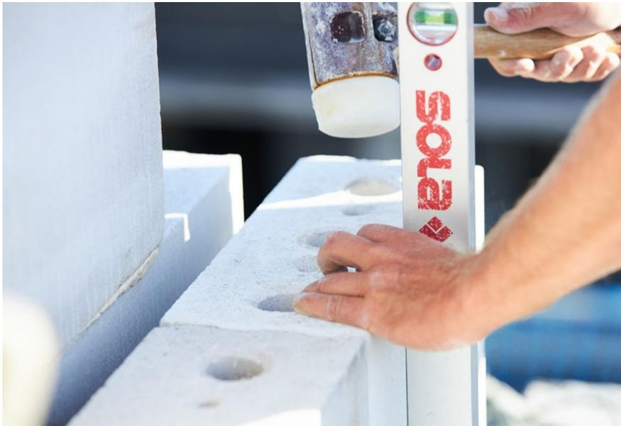
Das KS-QUADRO E System ermöglicht die einfache und substanzschonende Integration sämtlicher Elektroinstallationen, wie z. B. Stromleitungen, Telefon und Datenleitungen, Kommunikations- und Alarmanlagen sowie TV/BK/SAT-Anlagen in der Wand. Die hierfür zu nutzenden, vertikalen Installationskanäle ( $\varnothing < 40$  mm) sind in der Mitte der KS-QUADRO E Steine und im Abstand von 12,5 cm angeordnet.
